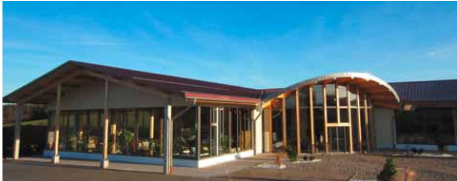
Effizient versorgt – das Möbelhaus MÖM in Glonn
